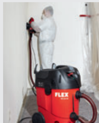
Het gips wordt afgefreesd. Afval en stof worden perfect door de FLEX veiligheidsstofzuiger VCE 45 H AC opgevangen.
