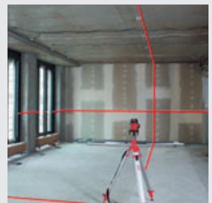
Zelfnivellerende multi-lijnlasers ALC 514 voldoet aan de hoogste eisen. Een permanent zichtbare laserlijn simuleert met een 180°-projectie de latere ruimtelijke indeling.
