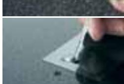
AKELUX Transparent Liquid mit AKELUX Filler farbig auf Steinfärbung abstimmen. Ggf. mit AKELUX Structure füllen und aushärten.
