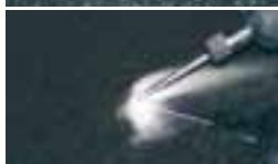
Manuelle oder maschinelle Ausfräsen der Schadstelle, Entfernen aller losen Teile.
