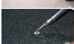
AKEMI SRS Primer zur Haftvermittlung auftragen und 60 sec trocknen lassen.
